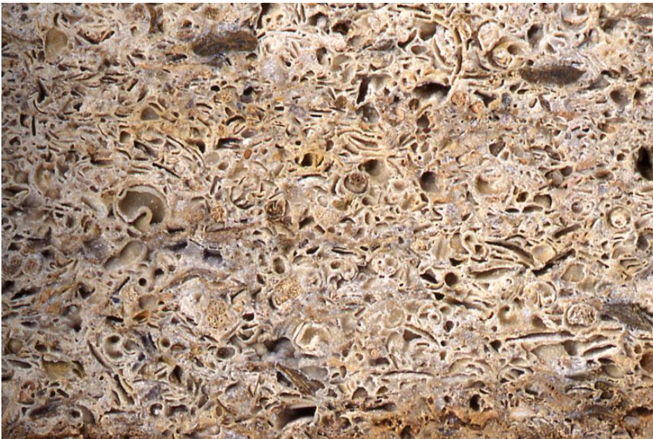
Fassadenplatte am Rathaus in Tengen aus Randen-Grobkalk
