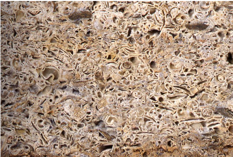
Fassadenplatte am Rathaus in Tengen aus Randen-Grobkalk
