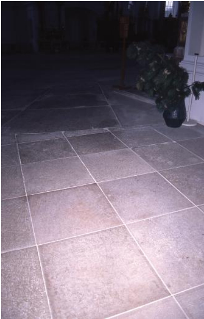
Boden aus Steinweiler Platten in der Abteikirche von Neresheim
