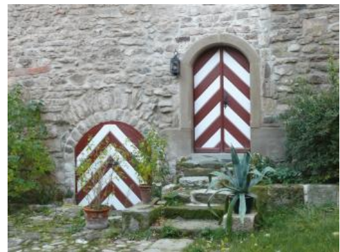
Teilweise aus Kieselsandstein bestehendes Blockmauerwerk im Schloss Honhardt bei Crailsheim
