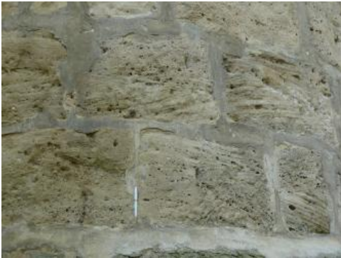
Typischer Blasensandstein im Blockmauerwerk des Turms der Tannenburg bei Bühlertann
