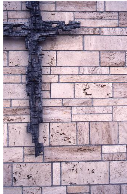
Verblendstein an der Aussegnungshalle in Horb a. N.-Dießen
