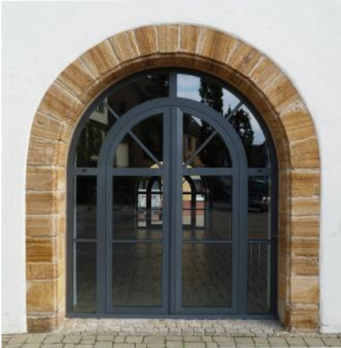
Renoviertes Portal am Rathaus in Neidlingen, Weilheimer Eisensandstein
