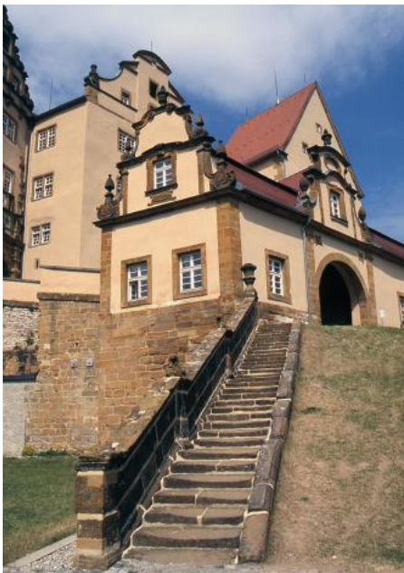
Schloss Kapfenburg bei Lauchheim mit Treppe aus Eisensandstein
