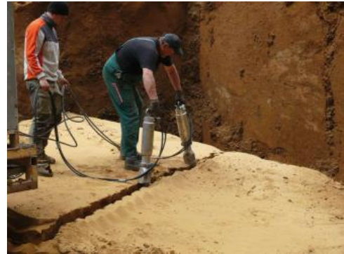
Hydraulisches Spaltgerät (Eisensandstein-Vorkommen der Banzenmühle bei Lauchheim)
