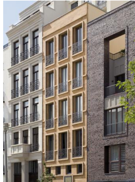
Cannstatter Travertin an einem Wohnhaus in Berlin-Mitte
