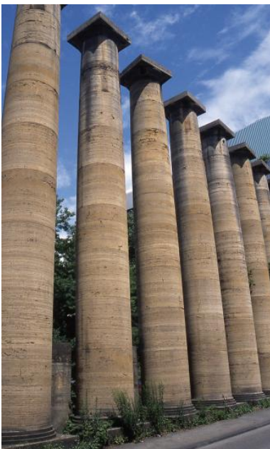
Travertinsäulen zwischen Steinbruch Lauster und Kraftwerk Münster
