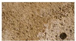
Fassadenplatte mit sandgestrahlter Oberfläche (Cannstatter Travertin)
