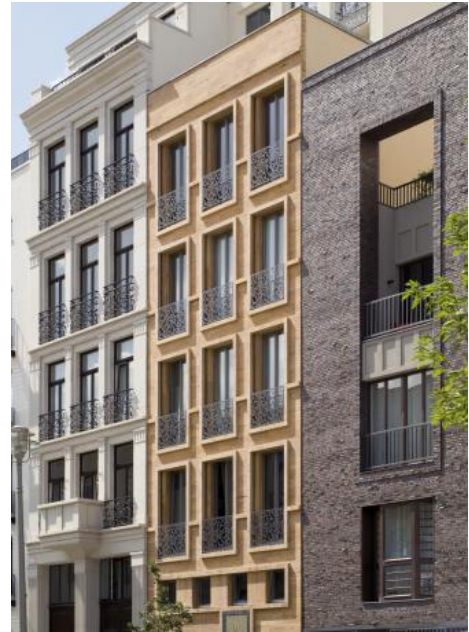
Cannstatter Travertin an einem Wohnhaus in Berlin-Mitte
