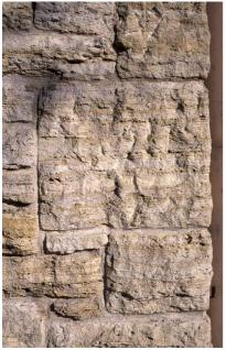
Mauerquader aus hellbeigem, regelmäßig geschichtetem Cannstatter Travertin
