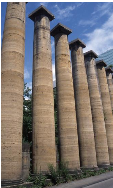
Travertinsäulen zwischen Steinbruch Lauster und Kraftwerk Münster
