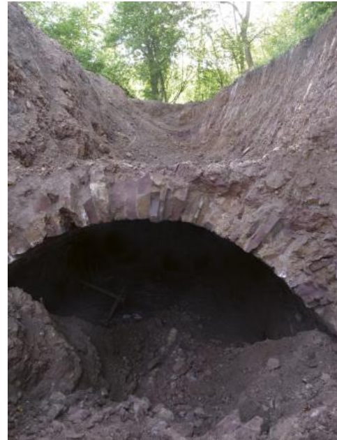
Durch Baggerarbeiten 2012 freigelegtes Portal des Oberen Schlierbergstollens
