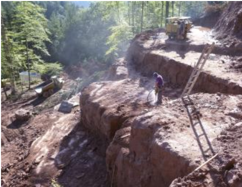
Abtragen der oberen Gesteinsschichten im Steinbruch am Langauweg, westlich von Tennenbach
