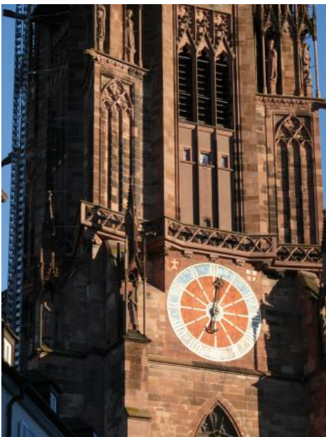
Turm des Freiburger Münsters aus Sandsteinen des Mittleren Buntsandsteins
