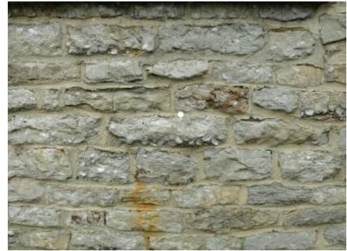
Detailaufnahme aus einer Arietenkalkmauer
