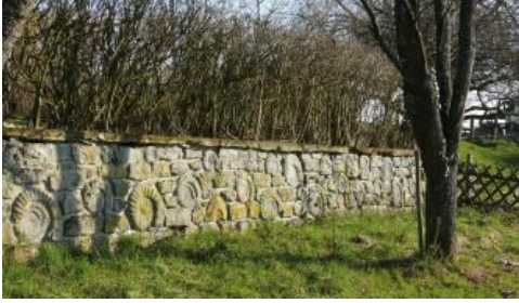
Gartenmauer aus Arietenkalk
