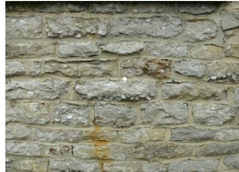
Detailaufnahme aus einer Arietenkalkmauer
