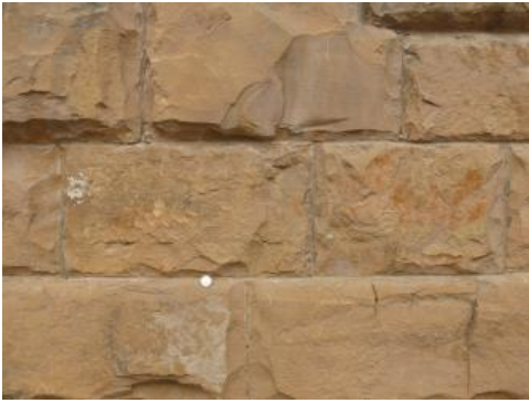
Sockelmauerwerk aus Angulatensandstein
