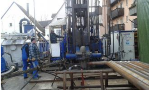
Bohrarbeiten zum Absenkbrunnen BB 4
