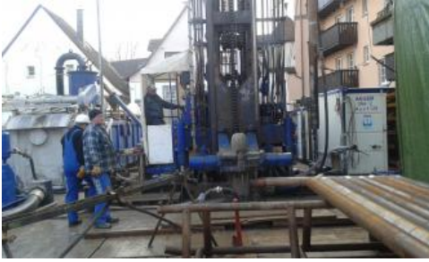
Bohrarbeiten zum Absenkbrunnen BB 4
