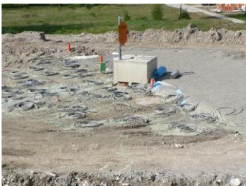
Bau eines Erdsonden-Wärmespeichers (Stober & Bucher, 2014)
