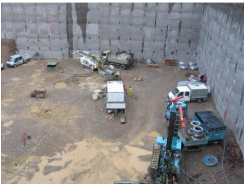
Errichtung eines Erdwärmesondenfeldes in einer Baugrube. Die einzelnen Erdwärmesondenrohre ragen aus der Baugrube heraus
