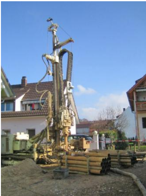
Bohrung für eine Erdwärmesonde
