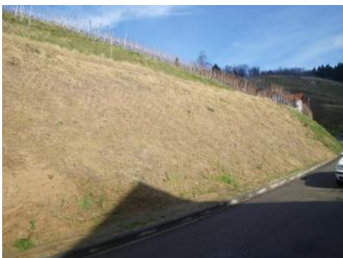
Sanierte Böschung an der Schelzbergstraße (Böschungsbruch 1 und 2)
