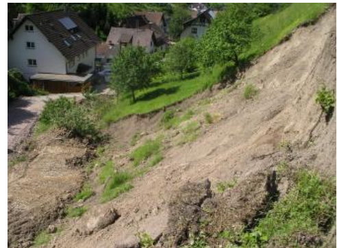
Böschungsbruch an der Schelzbergstraße. Links im Bild ist die provisorische Notfallüberfahrt zu sehen.
