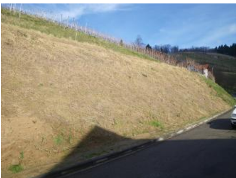
Sanierte Böschung an der Schelzbergstraße (Böschungsbruch 1 und 2)
