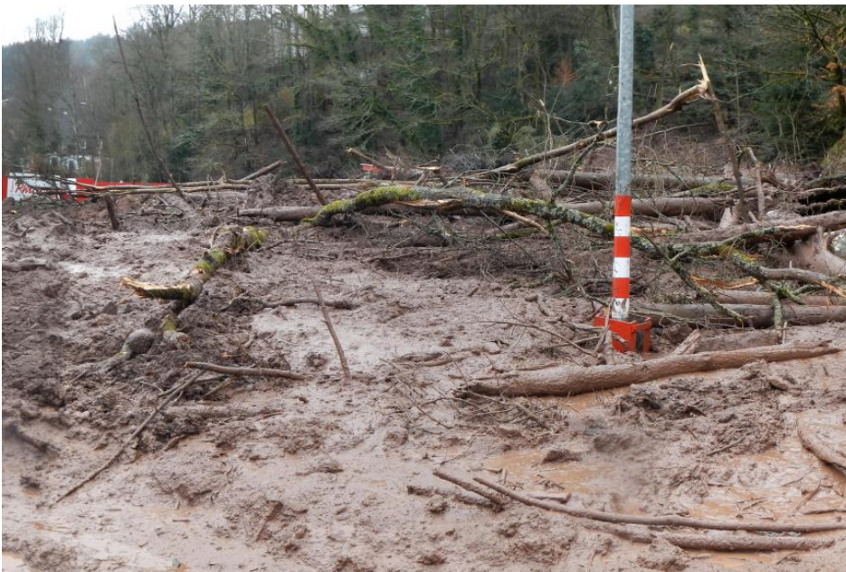
Panoramabild der Murgangmassen auf dem Parkplatz des Verbrauchermarktes
