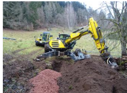
Herstellung einer Hangdrainage mit Hilfe eines Schreitbaggers im rückwärtigen Hang des Abrissbereiches
