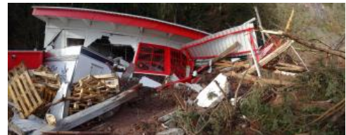
Durch den Murgang vollständig zerstörtes Nebengebäude
