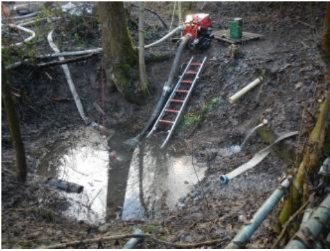
Eingerichteter, provisorischer Pumpensumpf, welcher in den ersten 48 Stunden durch die örtliche Feuerwehr betrieben wurde
