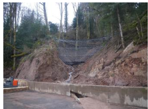
Geräumter Parkplatz am Ausgang der Hangklinge mit Murgangbarriere
