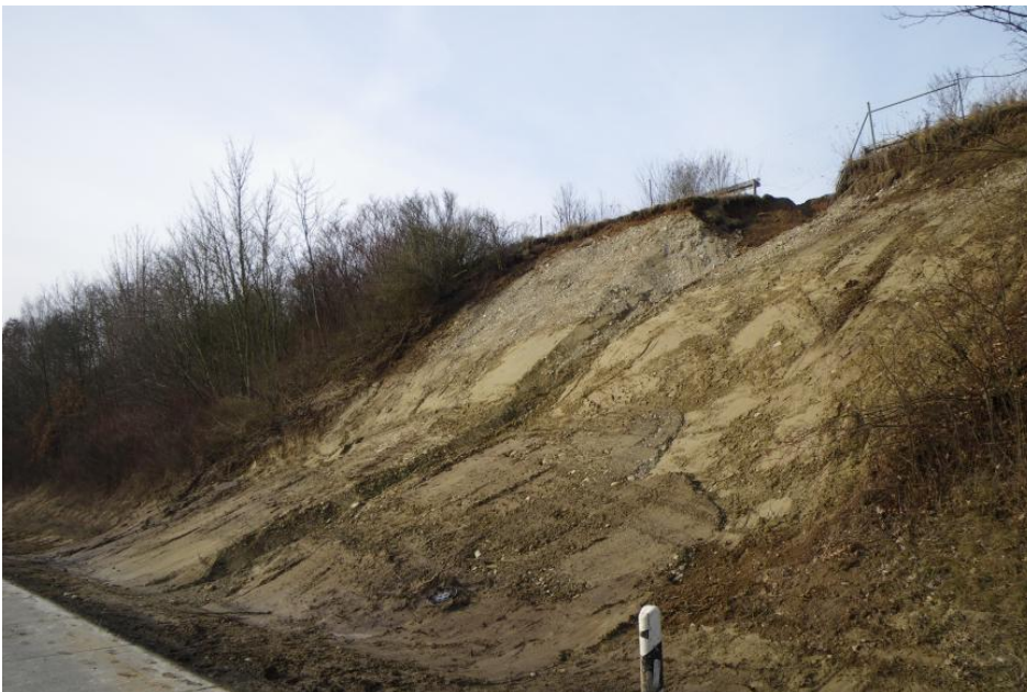
Temporäre Reprofilierung der Böschung am 26.01.2009
