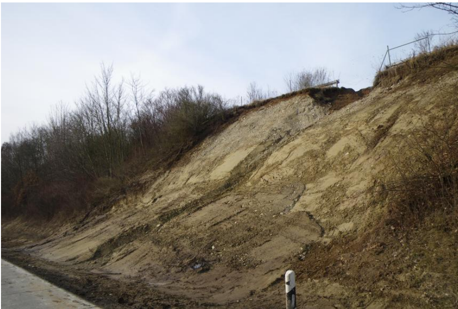
Temporäre Reprofilierung der Böschung am 26.01.2009
