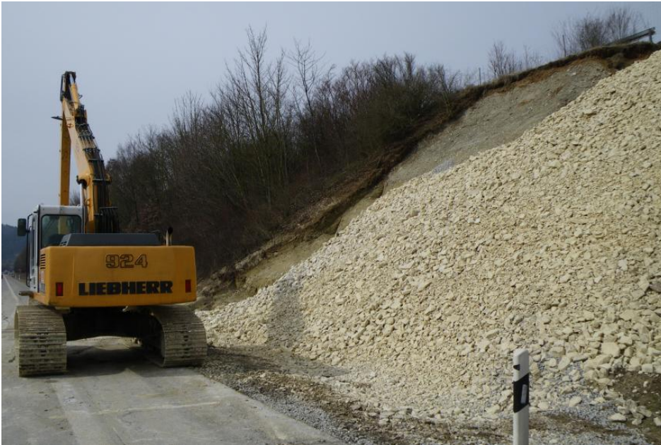
Abschließende Wiederaufbaumaßnahmen der Böschung am 17.03.2009
