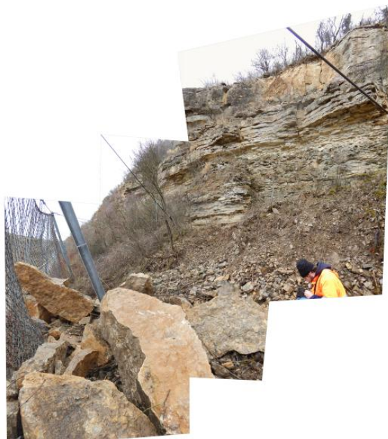
Prozessraum des Felssturzes von 2021
