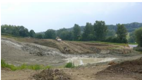
Abbau in der Tongrube Herdwangen-Schönach-Großschönach
