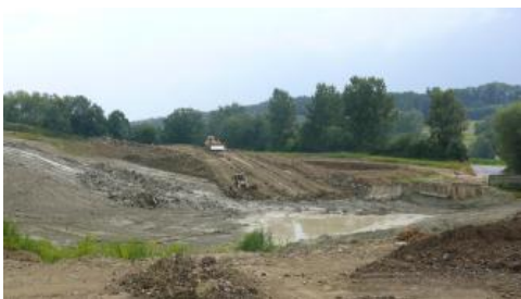
Abbau in der Tongrube Herdwangen-Schönach-Großschönach
