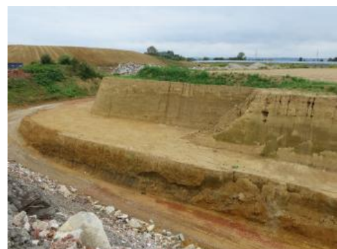
Abbau von quartärem Lösslehm über Deckenschottern und Schichten der Molasse
