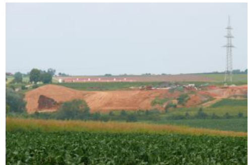
Abbau von quartärem Lösslehm und aufgearbeitete Tonsteine der Grabfeld-Formation.
