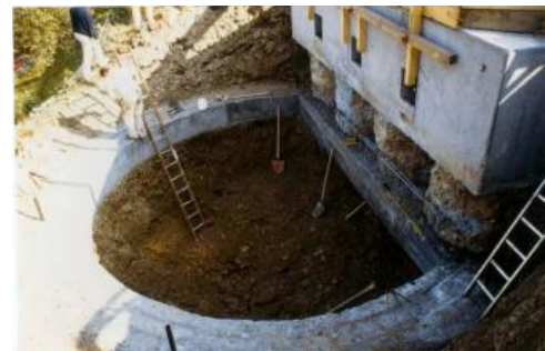
Herstellung eines Brunnens
