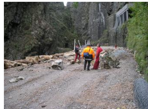
B31 während der Räumarbeiten
