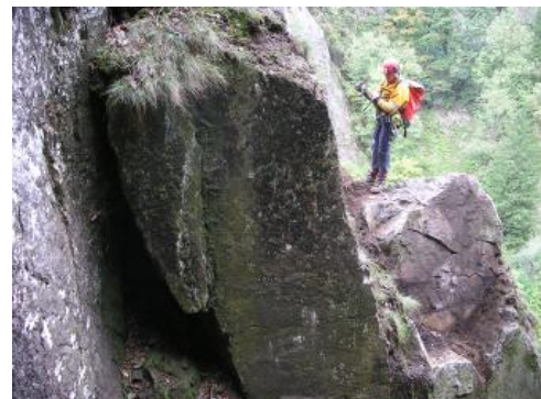
Labile, absturzgefährdete Felspartie am Hohfelsen
