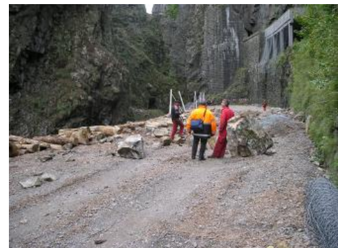
B31 während der Räumarbeiten
