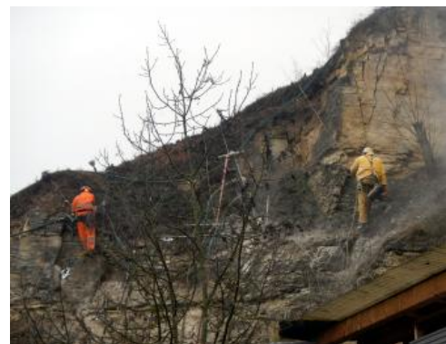
Arbeiten während Erstellung der Sicherungsmaßnahmen
