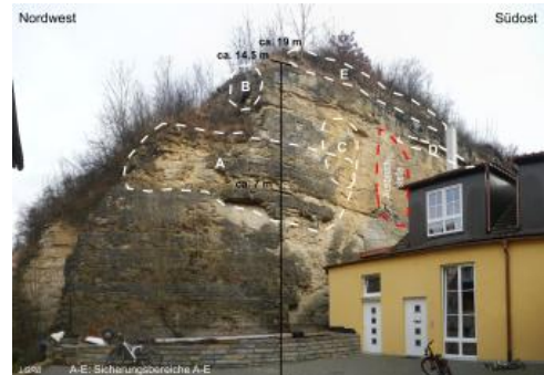
Übersichtsaufnahme von Westen in Blickrichtung der Ausbruchsstelle
