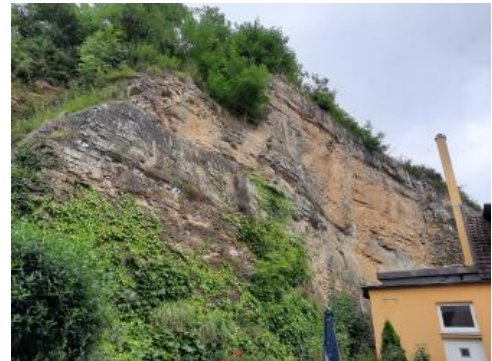
Ausschnittsweise Ansicht der ausgeführten Sicherungsmaßnahmen
