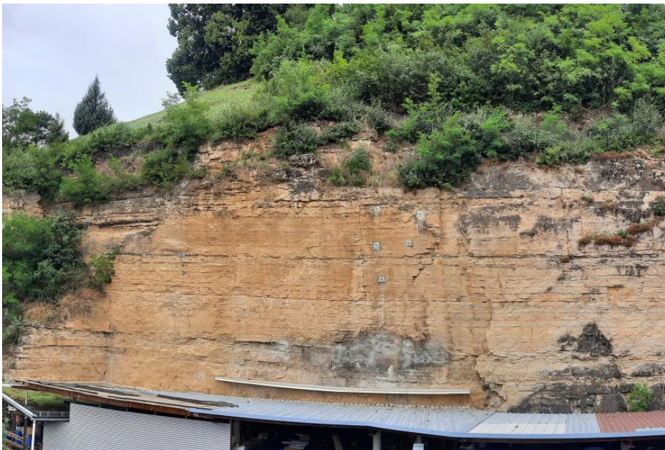
Ausschnittsweise Ansicht der ausgeführten Sicherungsmaßnahmen
