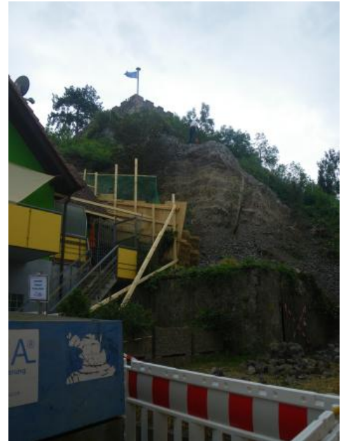
Prozessraum und Sofortsicherungsmaßnahmen
