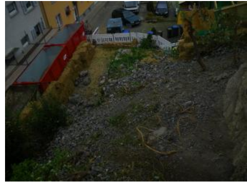
Ausbildung eines Sturzraumes als Sofortmaßnahme
