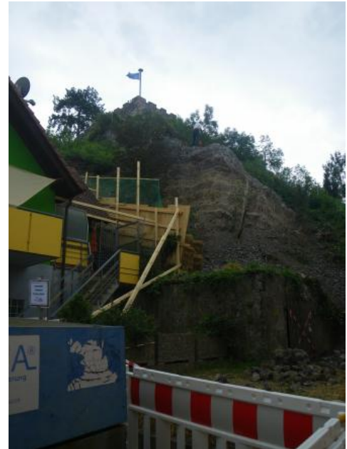
Prozessraum und Sofortsicherungsmaßnahmen
