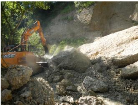
Bagger beim Beräumen des Bachbettes
