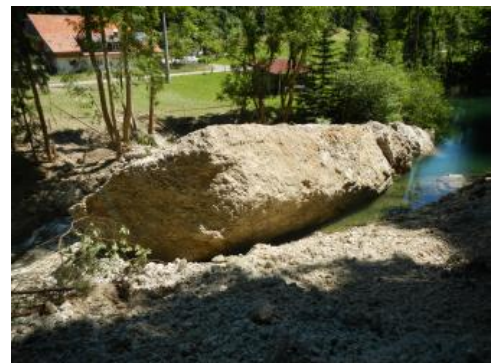
Sturzblock von insgesamt etwa 800 Kubikmeter blockiert den Abfluss der Eschach
