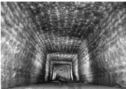
Abbaukammer im Steinsalzbergwerk Heilbronn
