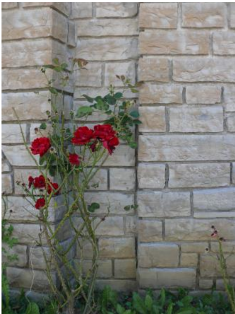
Bruchsteinmauer aus Kalkstein (Posidonienschieferhorizont)
