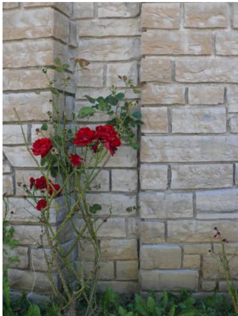
Mauer aus Kalksteinen aus dem Posidonienschieferhorizont des Unteren Steins
