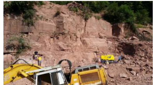
Durch Bohren und Keilen werden Rohblöcke gelöst.
