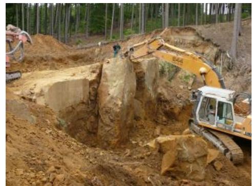
Lösen eines Steinblocks mit dem Reißbagger
