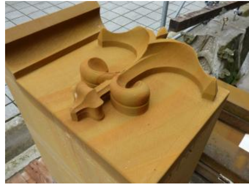
Maßwerk aus Lauchheimer Eisensandstein
