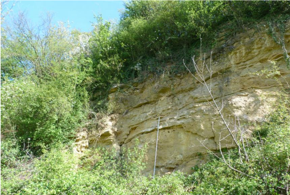
Wechselagerung plattiger Mergelsteine
