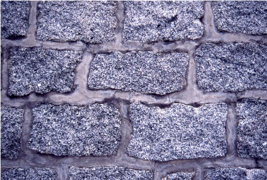
Die Fassadenverblendung eines Wasserbehälters in Ober-Laudenbach aus Granodiorit
