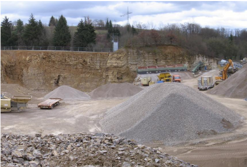
Übersicht über den Steinbruch Rheinfelden-Karsau mit Blick nach Osten
