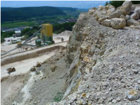
Blick über den Steinbruch Geisingen mit Förderanlage
