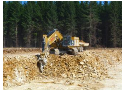
Rohstoffgewinnung im natürlich aufgelockerten Kalkstein durch Reißen und Baggern
