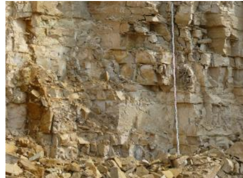
Detailaufnahme von Bankkalksteinen mit Mergelsteinlagen
