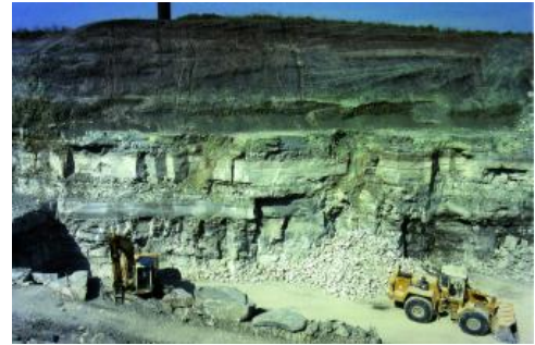
Abbau des Gipslayers der Grundgipsschichten
