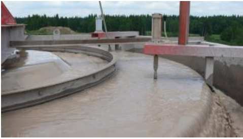
Hydroklassierung in der Sandaufbereitung.
