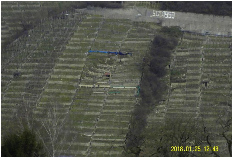
Rutschung 2018 unterhalb des Wurmbergweges
