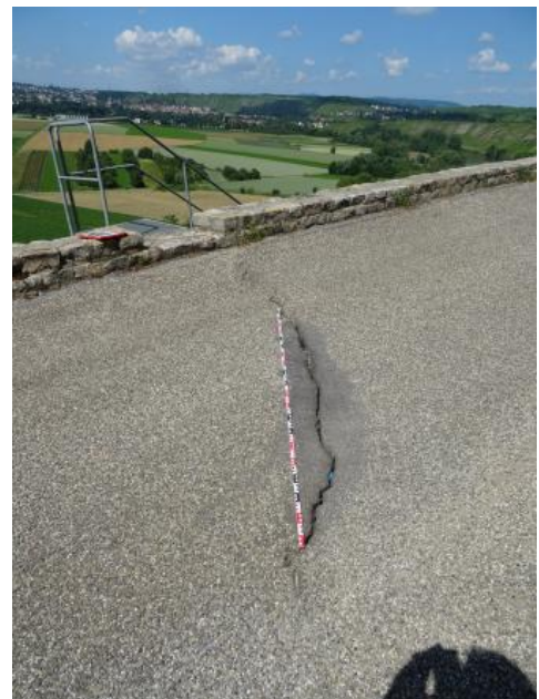
Riss innerhalb des Wurmbergweges (Aufnahme 2020)
