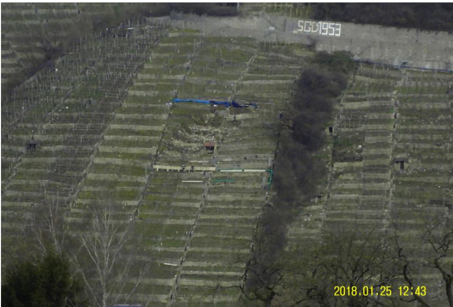
Rutschung 2018 unterhalb des Wurmbergweges
