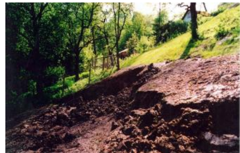
Rutschung in Stuttgart-Vaihingen
