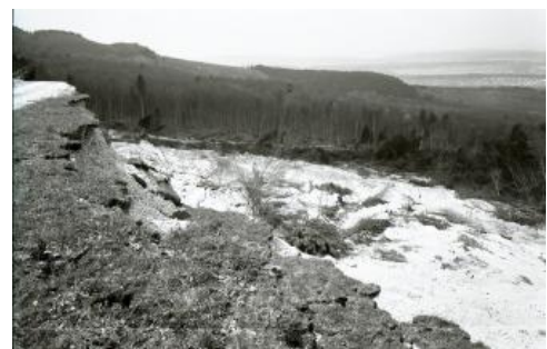
Untergeordnete Abrisskante mit „Kieswüste“
