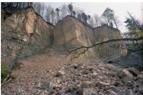
Abrisswand mit absitzender Scholle
