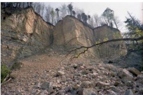
Abrisswand mit absitzender Scholle
