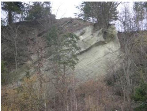
Rutschungsscholle der Rutschung „Sipplinger Dreieck“ mit verkippten Festgesteinskörpern
