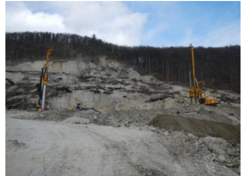
Erstellung einer „Sickergalerie“
