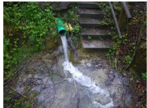
Auslass der basalen Tiefenentwässerung am Öschenbach
