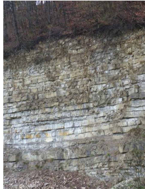
Impressamergel-Formation, darüber Wohlgeschichtete-Kalke-Formation, Straßenböschung bei Tuttlingen
