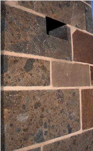
Ausschnitt vom Mauerwerk am Treppenturm des Breisacher Münsters
