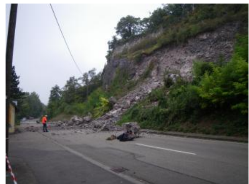
Felssturz in Sasbach unterhalb der Ruine Limburg
