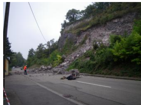
Felssturz in Sasbach unterhalb der Ruine Limburg
