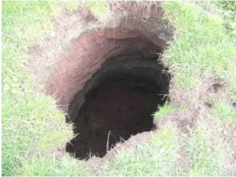
Erdfall bei Schwäbisch Hall
