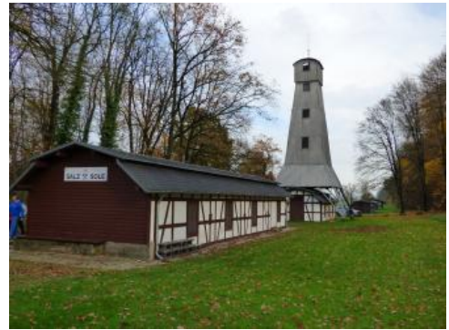
Sole aus Bad Rappenau für den Bäderbetrieb
