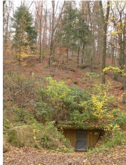
Mundloch der Grube Marie in der Kohlbach bei Hohensachsen
