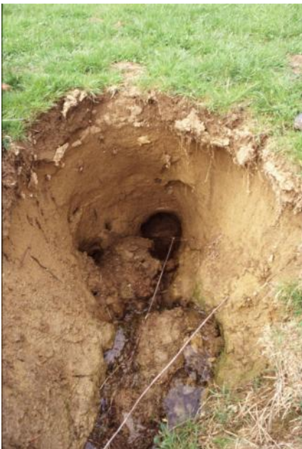
Erdfall infolge von Tunnelerosion im Markgräfler Hügelland südlich von Schliengen-Obereggenen
