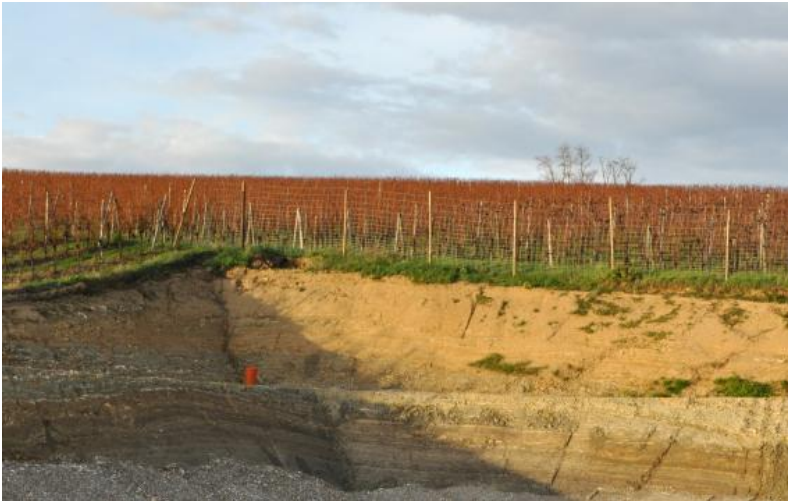
Baugrube bei Sulzburg-Laufen mit geringmächtigem Löss über tertiärem Mergel
