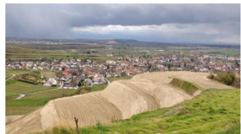
Anlage neuer Lössterrassen bei der Flurneuordnung Ihringen 2014
