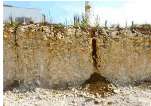
Lehmverfüllte Karstspalten in einer Baugrube bei Grabenstetten
