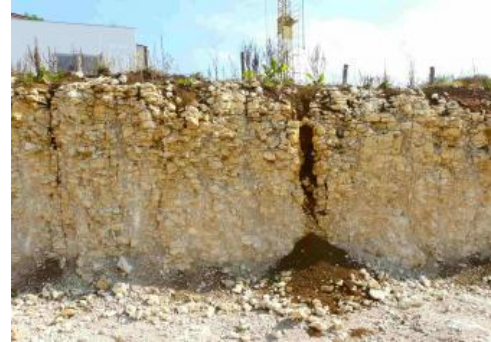
Lehmverfüllte Karstspalten in einer Baugrube bei Grabenstetten
