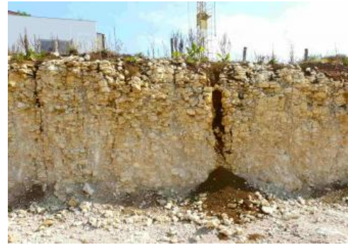
Lehmverfüllte Karstspalten in einer Baugrube bei Grabenstetten
