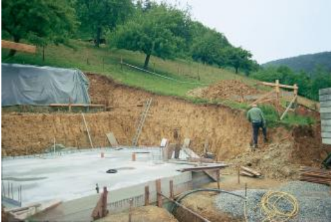
Baugrube an einem südost-exponierten Unterhang im Neckartal bei Horb-Dettingen
